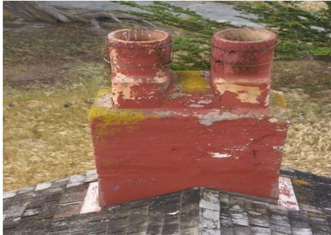
Figure #32 : TYPICAL CONDITION OF CHIMNEY SYSTEM **POOR**.
