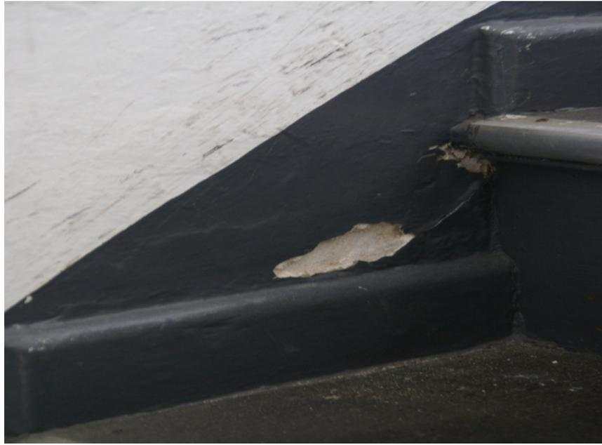
Figure # 18 : DAMAGE TO WALL PLASTER ALONG STAIR TREAD.
